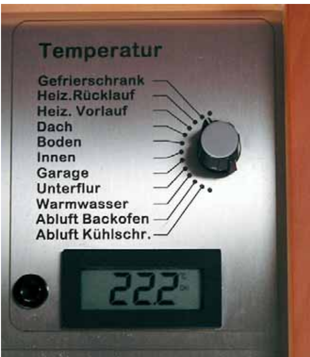
Temperaturabfrage im Controlpanel
