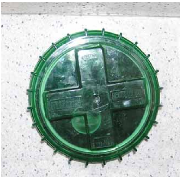
Aktivkohlefilter für WC-Entlüftung
