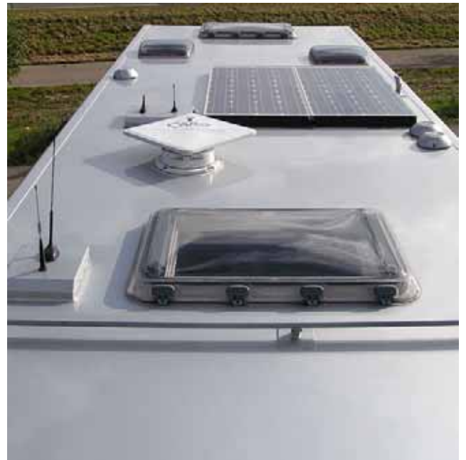
Dachaufbauten von vorne gesehen
