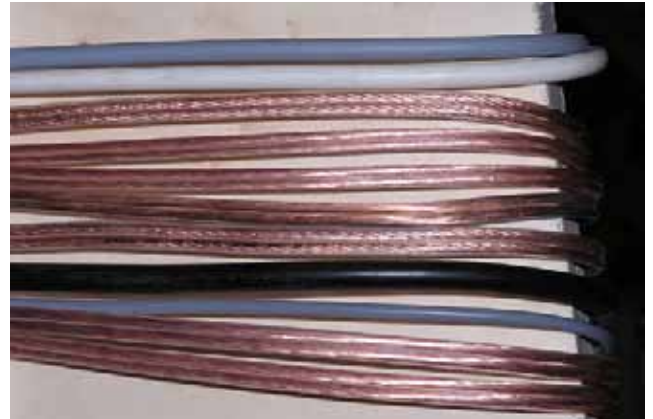
Verlegung diverser Leitungen
