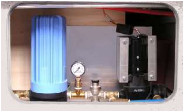
Spezialfilter mit Manometer, Druckminderer und Pumpe
