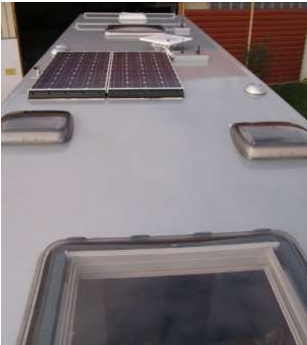
Dachaufbauten von hinten gesehen
