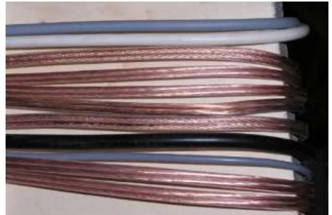
Verlegung diverser Leitungen
