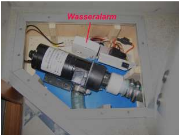
Überarbeitete Häckslerpumpe, jetzt mit Wasseralarm
