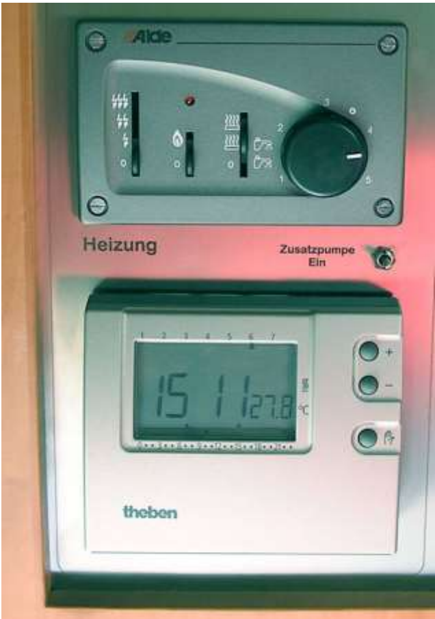
Heizungssteuerung im Controlpanel
